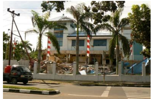
Gambar 6. Gedung ABA LIA mengalami patah struktur pada lantai 1 dan 2
