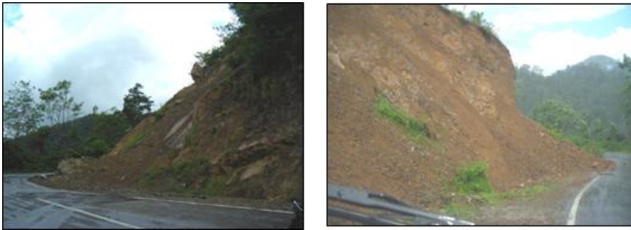
Foto 1. Foto beberapa longsor yang terjadi pada pemotongan lereng pada ruas jalan Wonosobo – Bengkunat. Nampak separuh badan jalan yang tertutup oleh tanah pelapukan batuan breksi dan lava dari Formasi Hulusimpang, jenis longsorannya adalah aliran.
