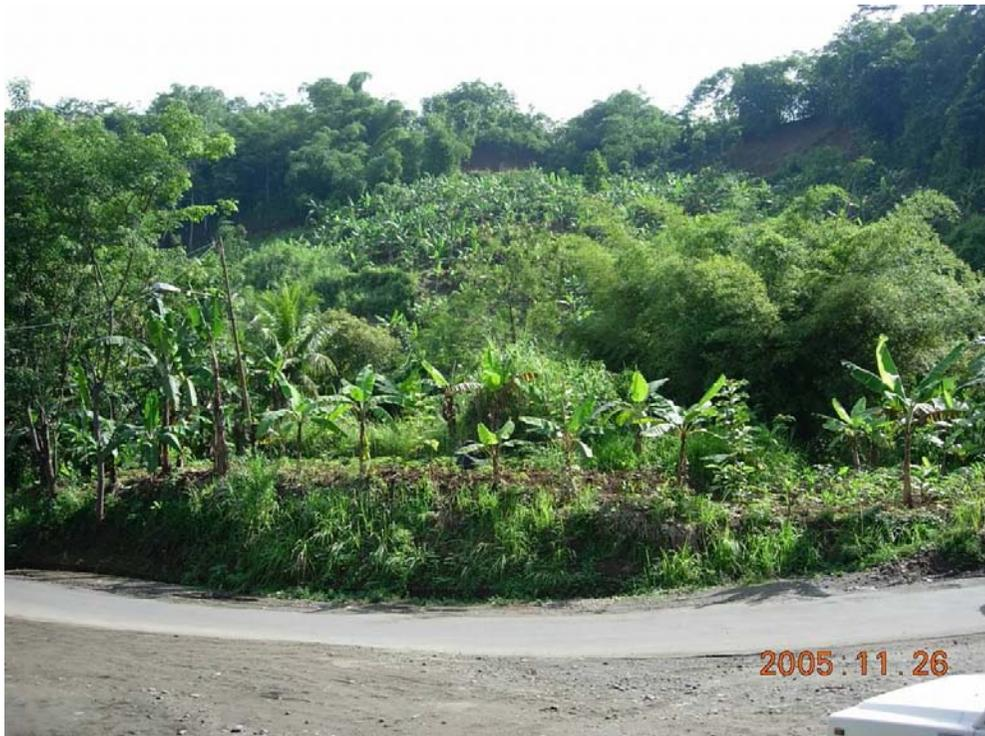
Gambar 7 : Tanah longsor Warungkiara, Sukabumi. (Terlihat mahkota longsor, ongkakan rombakan tanah longsor yang pindah dan jalan asphalt amblas)
