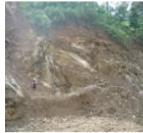
Tufa breksi teralterasi dan lapuk, terjadi longsor di tepi jalan raya Wonosobo - Krui, Lampung, 2007.
