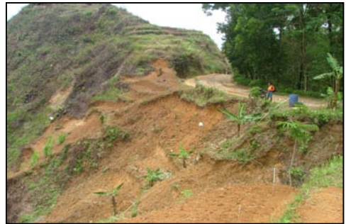
Gambar 6. Salah satu titik potensi gerakan tanah pada kemiringan lereng 40^{\circ} pada penggunaan lahan ladang yang jika berkembang dapat memutuskan akses jalan.
