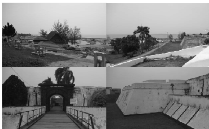
Gambar 6. Bangunan benteng Marlborough yang relatif tinggi dan kokoh dapat dijadikan alternatif jalur evakuasi vertikal
