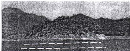
Foto 1. Penurunan muka air waduk
