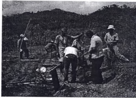
Gambar 4. Foto lokasi pengambilan data insitu dengan menggunakan sondir dan bor tangan.
